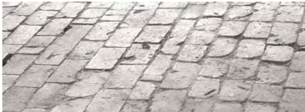
Piso del taller, con sus característicos adoquines de madera.
