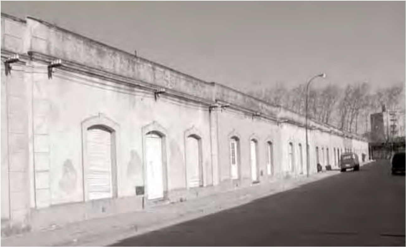
Casas de los obreros del ferrocarril en la calle Rivarola. Al fondo, el inconcluso edificio de la Unión Ferroviaria.
