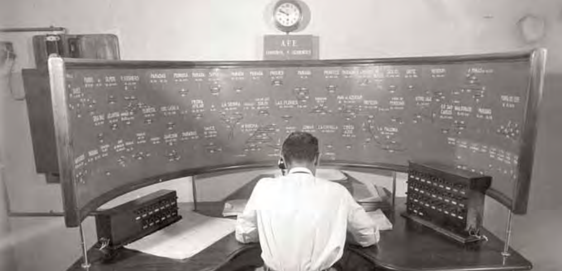
Cabina de controles en la playa de maniobras de la Estación Central.
